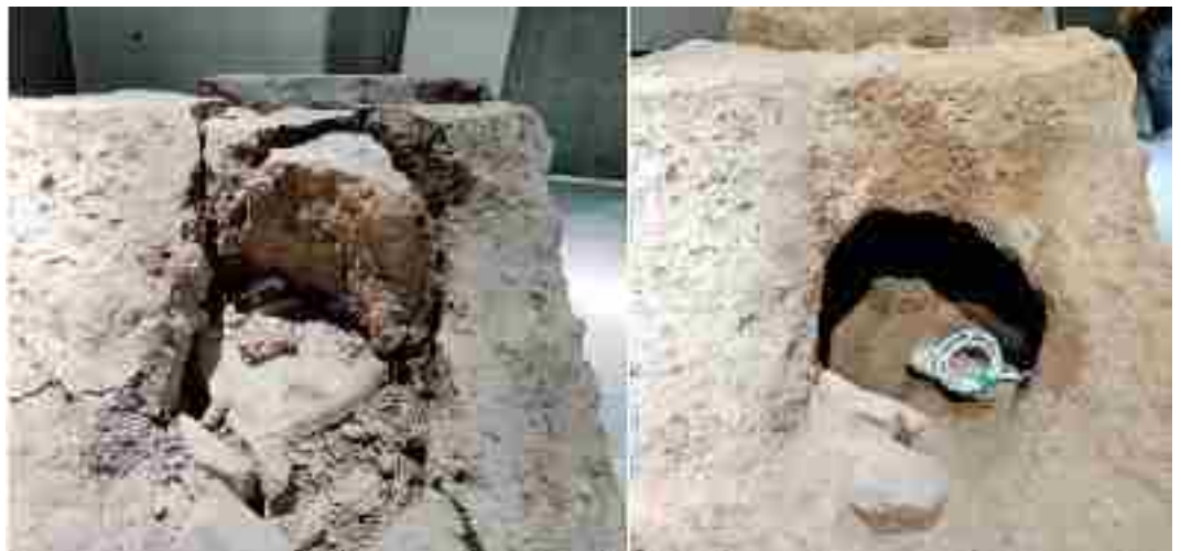
城烟遗址竖穴式升焰陶窑坍塌病害修复前（左）后（右）对比图
