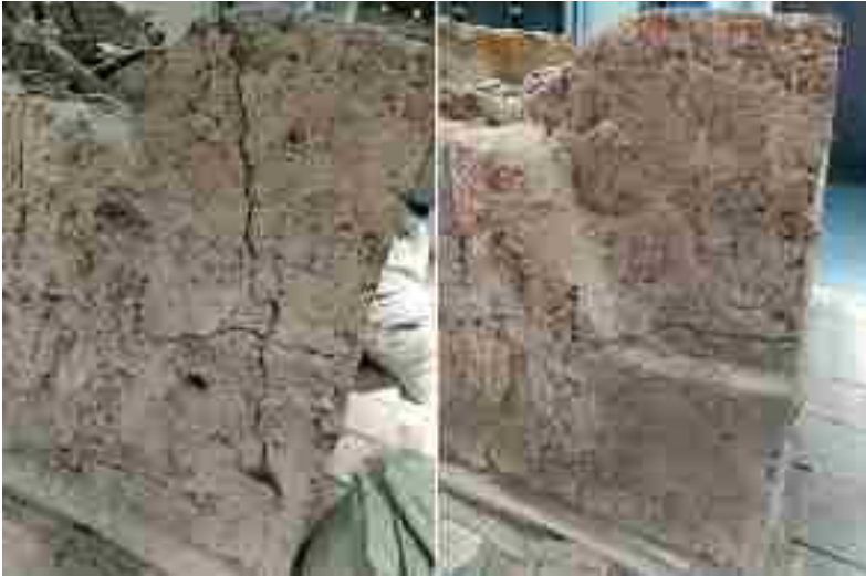
城烟遗址竖穴式升焰陶窑开裂病害修复前（左）后（右）对比图
